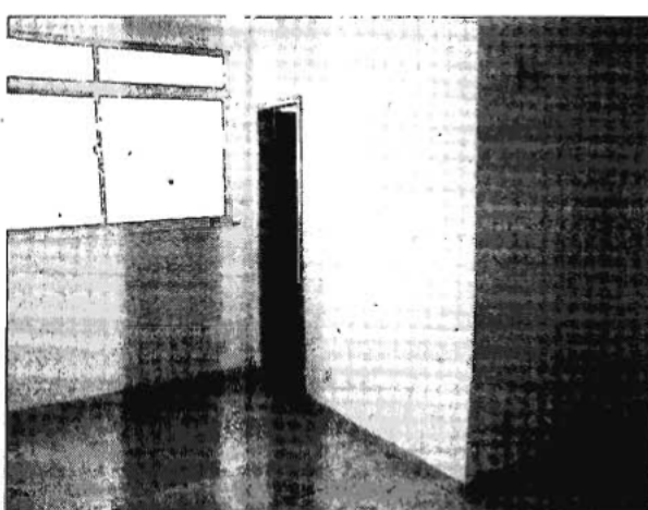
Sala com sanitário privativo (2º pavimento)
