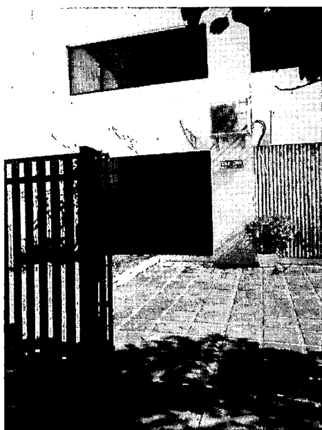
Fachada Principal e acesso
