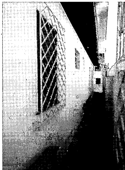
Área lateral da casa
