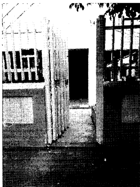
Pequeno desnível no acesso a casa
