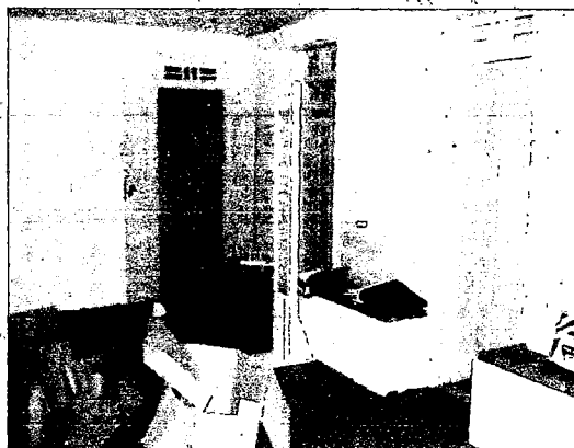
Portas estreitas – Imóvel 01 (Necessário alargamento)
