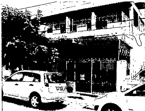
Acesso Sem acessibilidade
