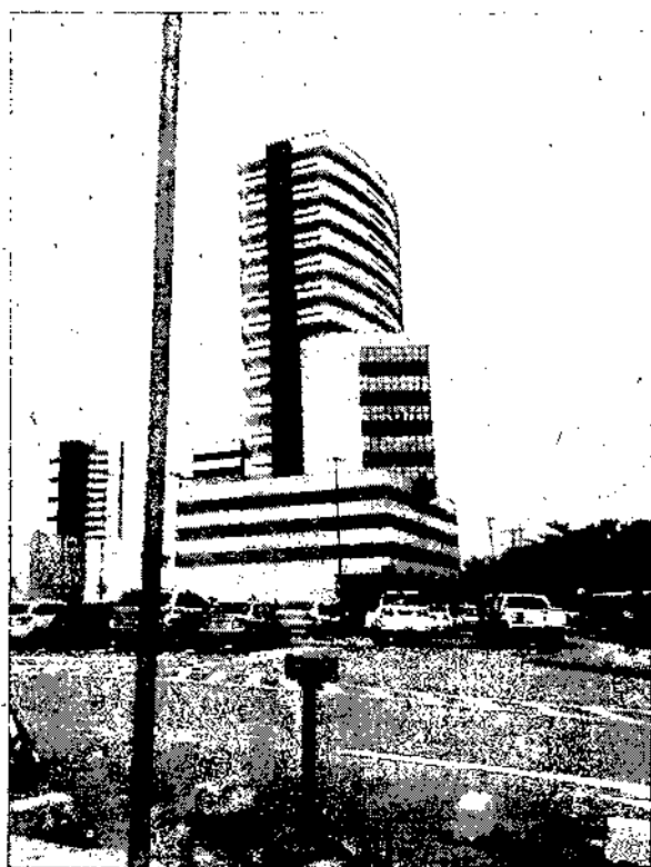
Vista externa da edificação
