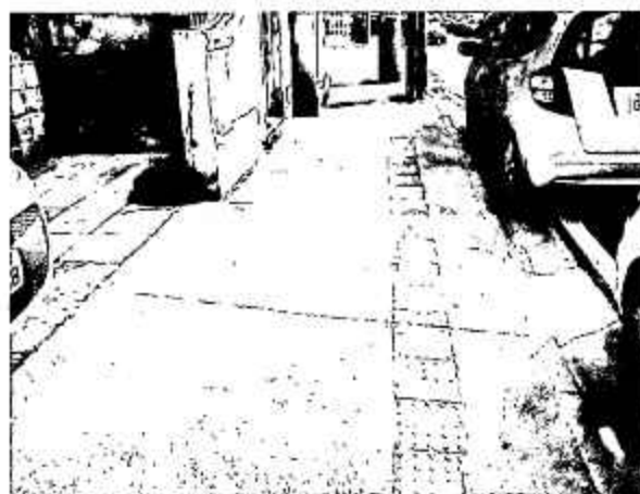
Passeio Público – Frente do imóvel
