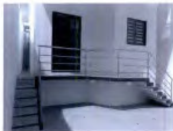
Figura 14 – Acesso ao Térreo
