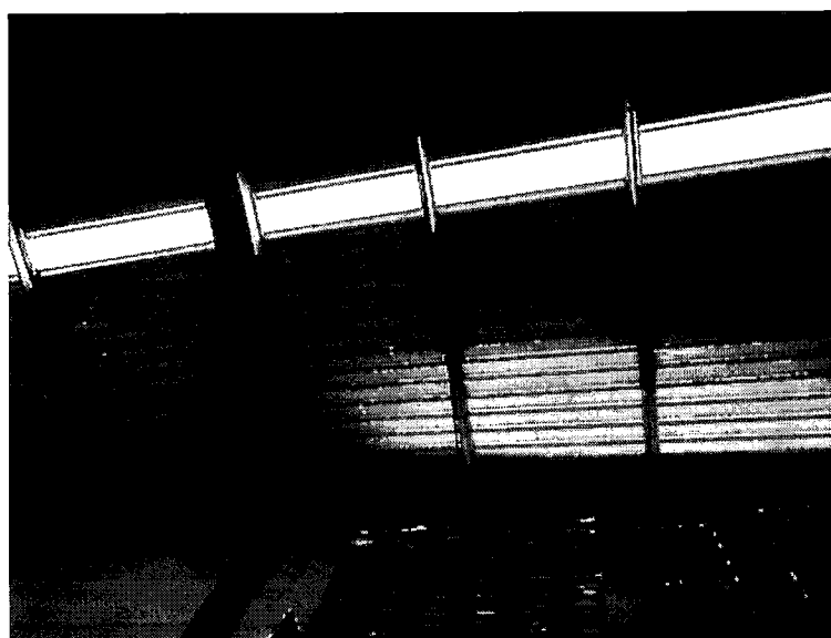
Figura 14 – Trecho da cobertura
