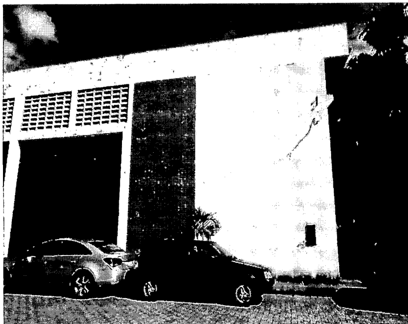
Figura 04 – Fachada do galpão
