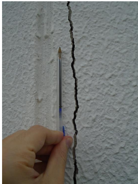
Trinca em detalhe
