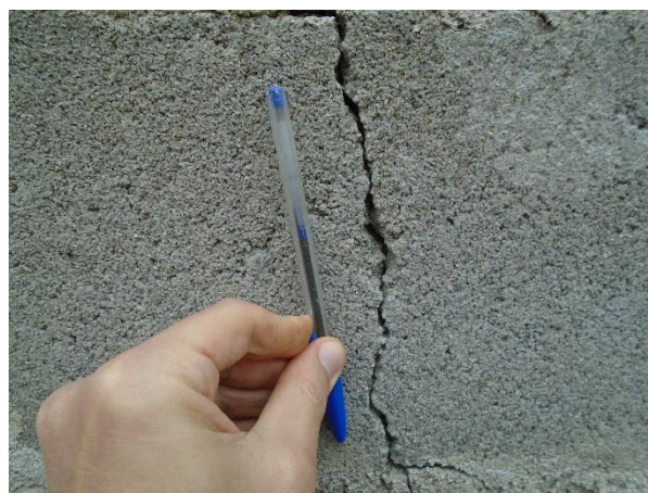
Trinca em detalhe
