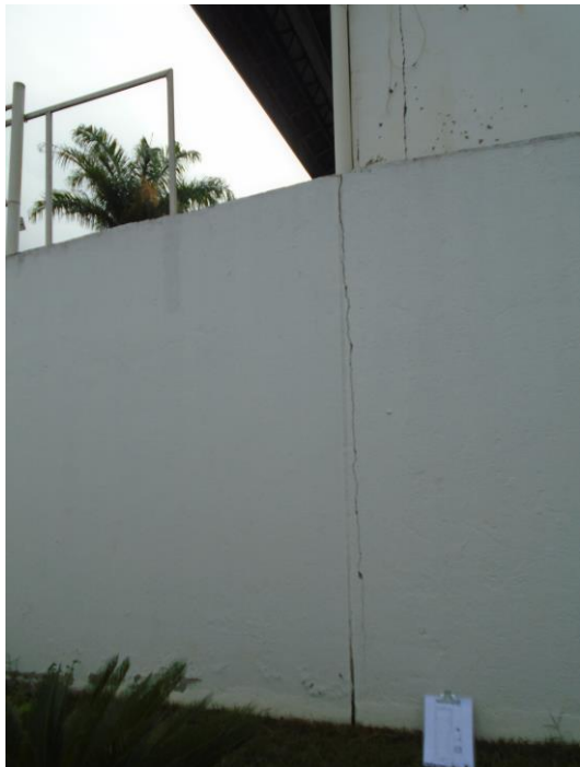
Trinca no trecho do muro vizinho à empresa concessionária de veículos
