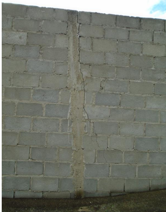
Pilar com seção reduzida e com trinca lateral (visão pelo TRT)
