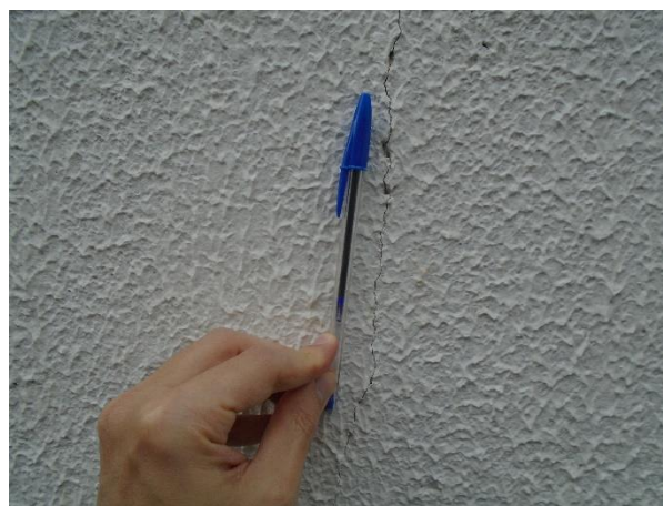
Trinca em detalhe
