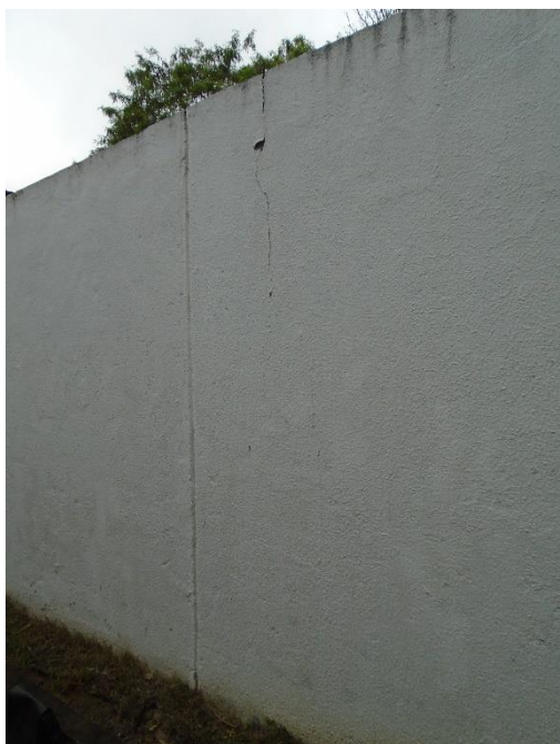
Trinca no trecho do muro vizinho a terreno desocupado (ao fundo da sede)
