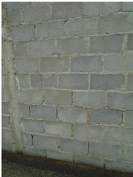
Trinca no trecho do muro no limite entre os terrenos do MPBA e do TRT (vista pelo TRT)
