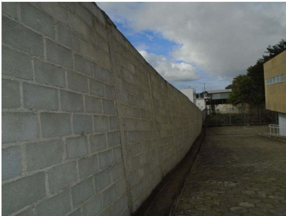
Trecho do muro implantado no limite dos terrenos entre o MPBA e o TRT com forte desaprumo
