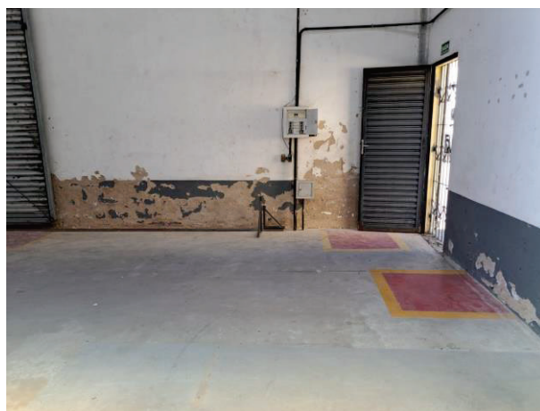
Figura 10 – Galpão 08 Reboco a Reparar
