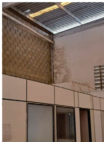
Figura 08 – Galpão 07 Infiltrações
