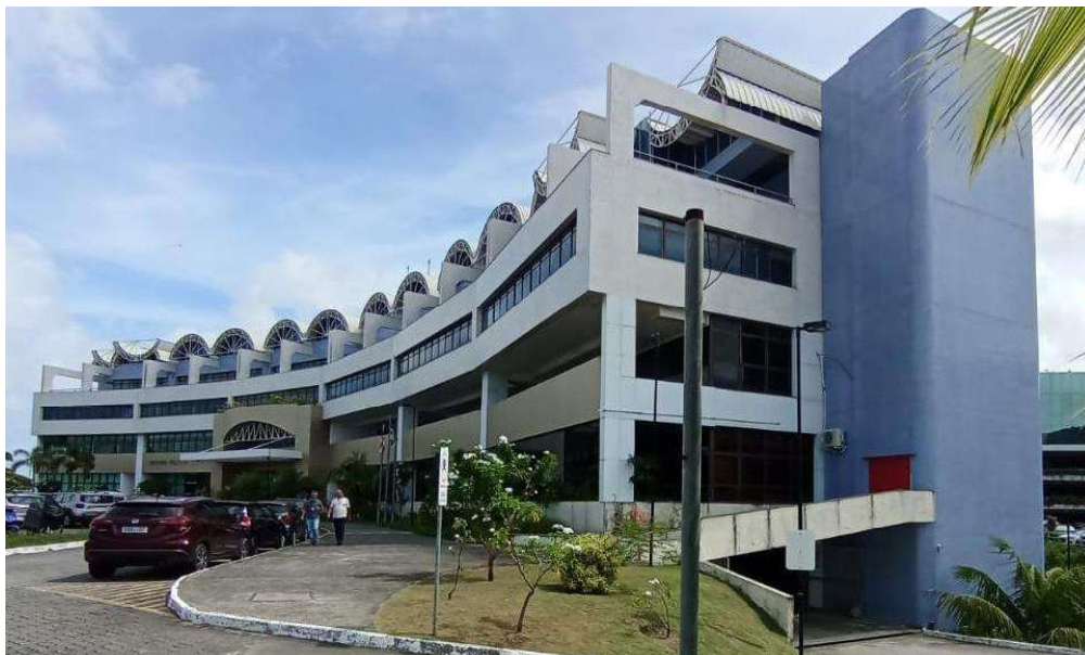
Foto 01 – Fachada Lateral Direita
