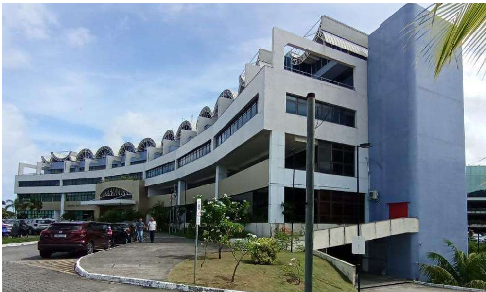
Foto 01 – Fachada Lateral Direita
