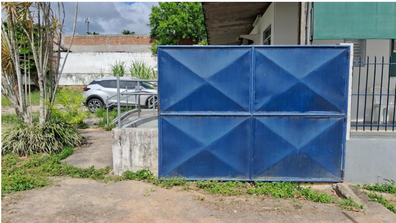
Portão de entrada a ser substituído (patamar para viabilizar a abertura do portão e pavimentação em concreto até o trecho onde começa a vaga para cadeirante)
