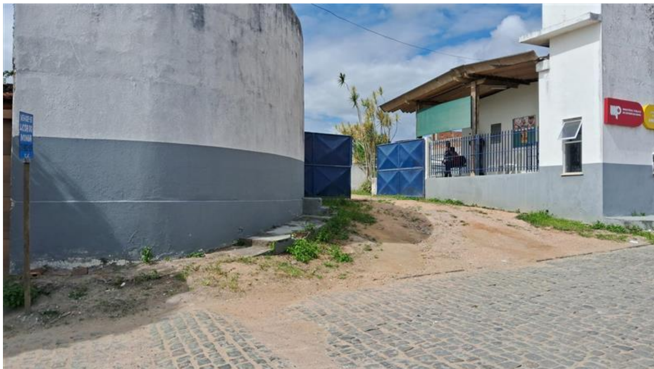
Entrada da Promotoria (trecho de meio fio a ser substituído; demolição do passeio existente, pintura da fachada da sala multiuso e pavimentação em concreto da rampa de entrada)
