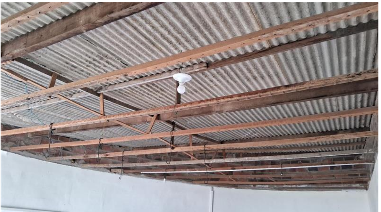
Telhado do salão multiuso (substituição do telhado de fibrocimento, instalação de forro removível em painel de gesso acartonado, instalação de luminárias)
