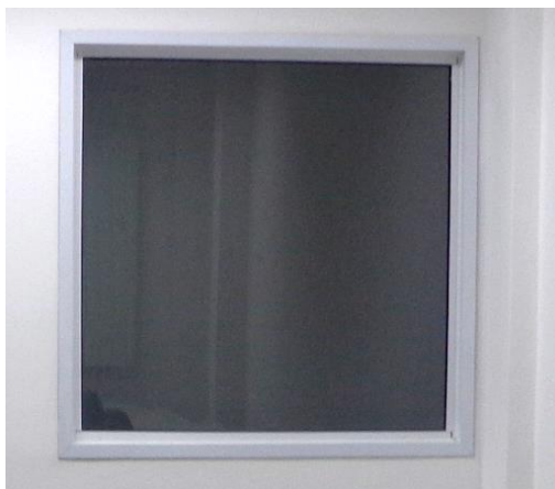
Figura 02 - Visor em alumínio com pintura eletrostática branca e vidro incolor 4mm com acabamento em cantoneira branca.
