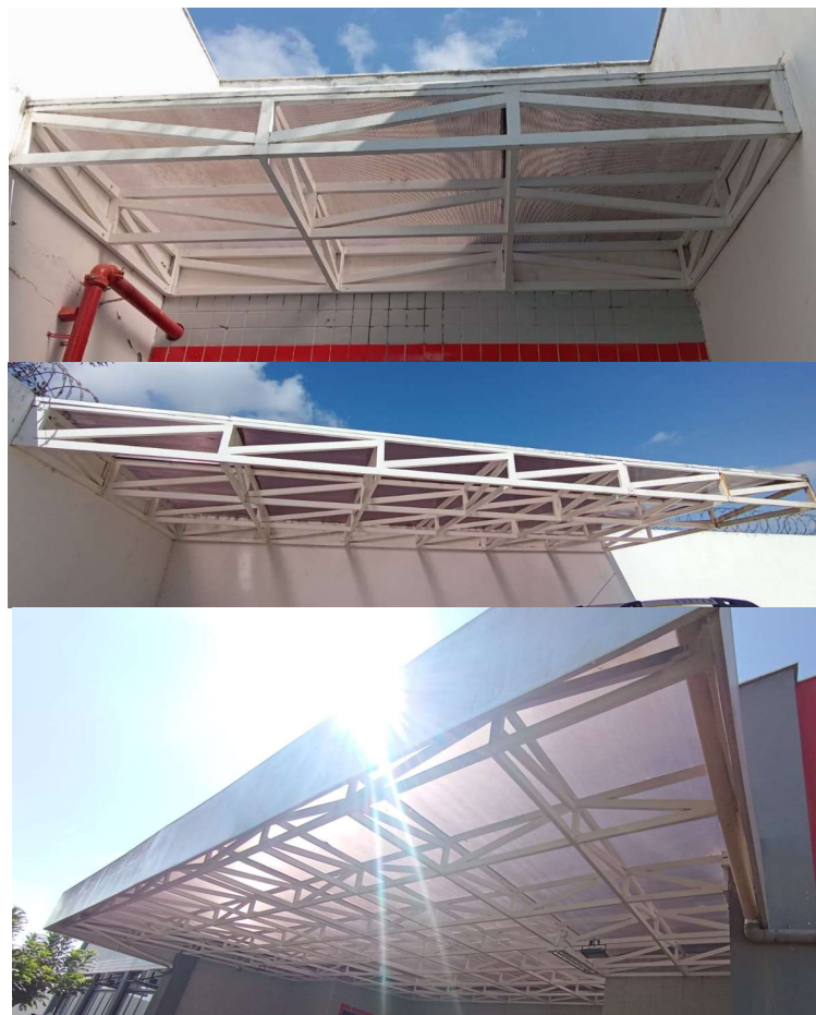
Foto 08 – Locais para Tratamento dos pontos de oxidação e pintura em estruturas metálicas (item 3.5 da planilha de detalhamento)
