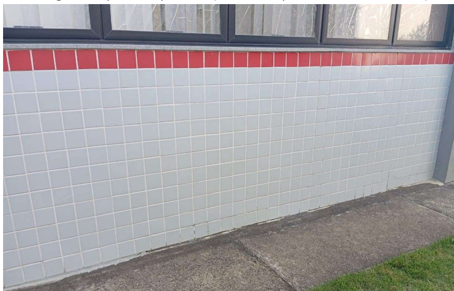
Foto 01 – Exemplo de local para manutenção em rejunte de fachada, incluindo a lavagem completa das pastilhas (item 1.3 da planilha de detalhamento)
