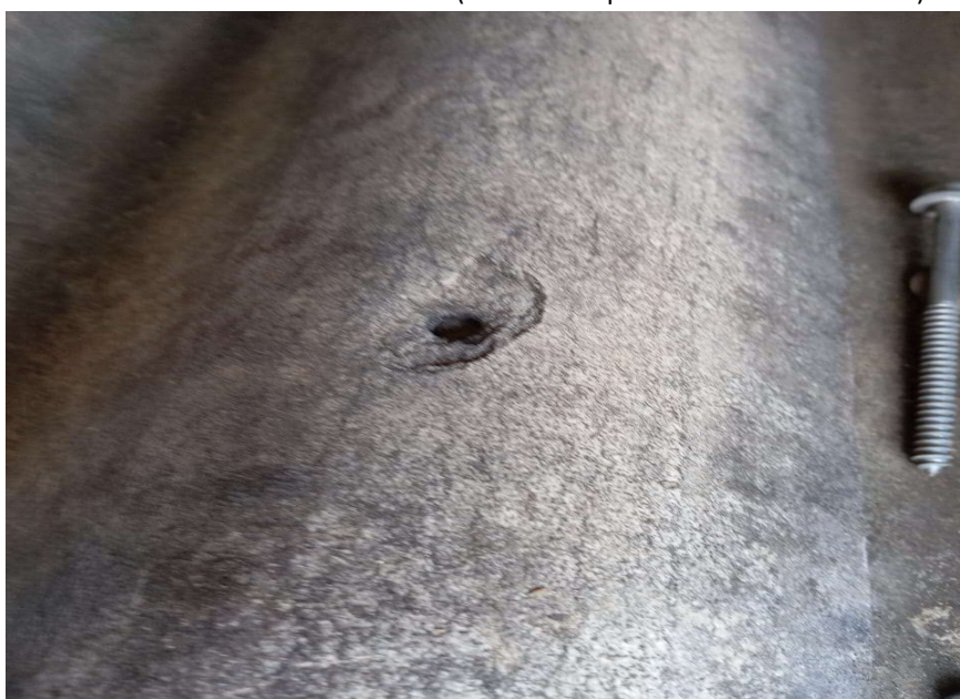
Foto 10 – Exemplo de local para aplicação de manta asfáltica aluminizada em pequenos furos do telhado de fibrocimento (item 4.1 da planilha de detalhamento)
