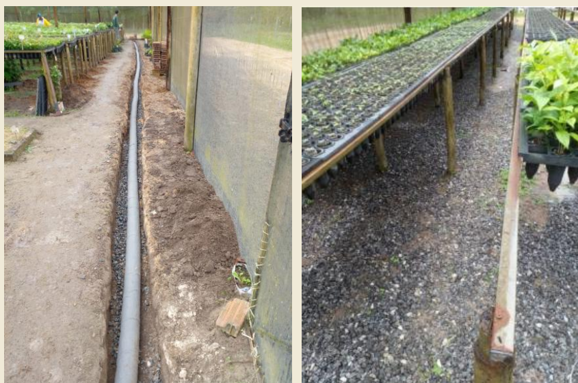
Figura 38. Adequação do escoamento da água da casa de sombra do viveiro
